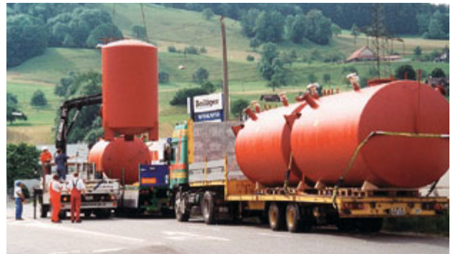
4 x 17 500 l Solarspeicher für SUVA Unternehmens- und Innovationszentrum
