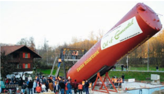
Aufstellen des 205 000 l Solarspeichers beim ersten 100% solar beheizten MFH Europas in CH-Oberburg
