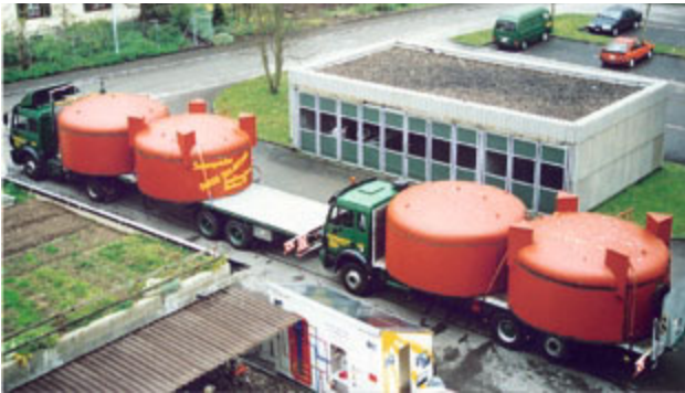
2 x 60 000 l Solarspeicher für Wohnüberbauung
