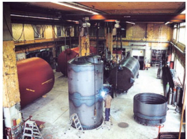
Werkhalle für Grossspeicher
